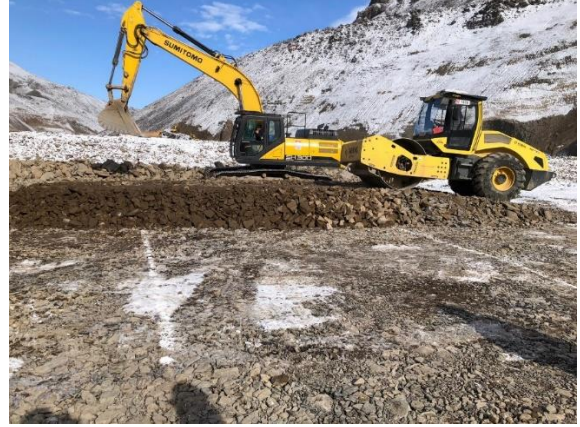
Şekil 1. Çerçeve içerisi ve çevresinde numune serimi ve standart sıkıştırma işlemi
