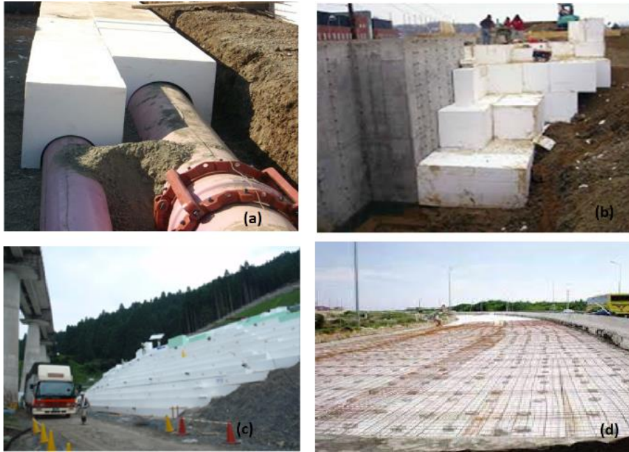
Şekil 1. EPS malzemesinin farklı geoteknik uygulamalarında kullanım durumları a) gömülü boru sistemlerinde, b) dayanma yapılarında, c) şev stabilitesinde, d) yol alt yapı dolgusunda
