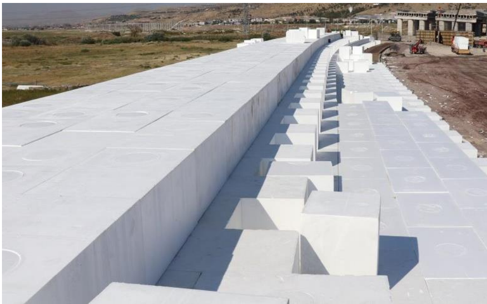
Şekil 4. Geofoam blokların blok yerleşim planına göre yerleştirilmesi, Boğazköprü/Kayseri
