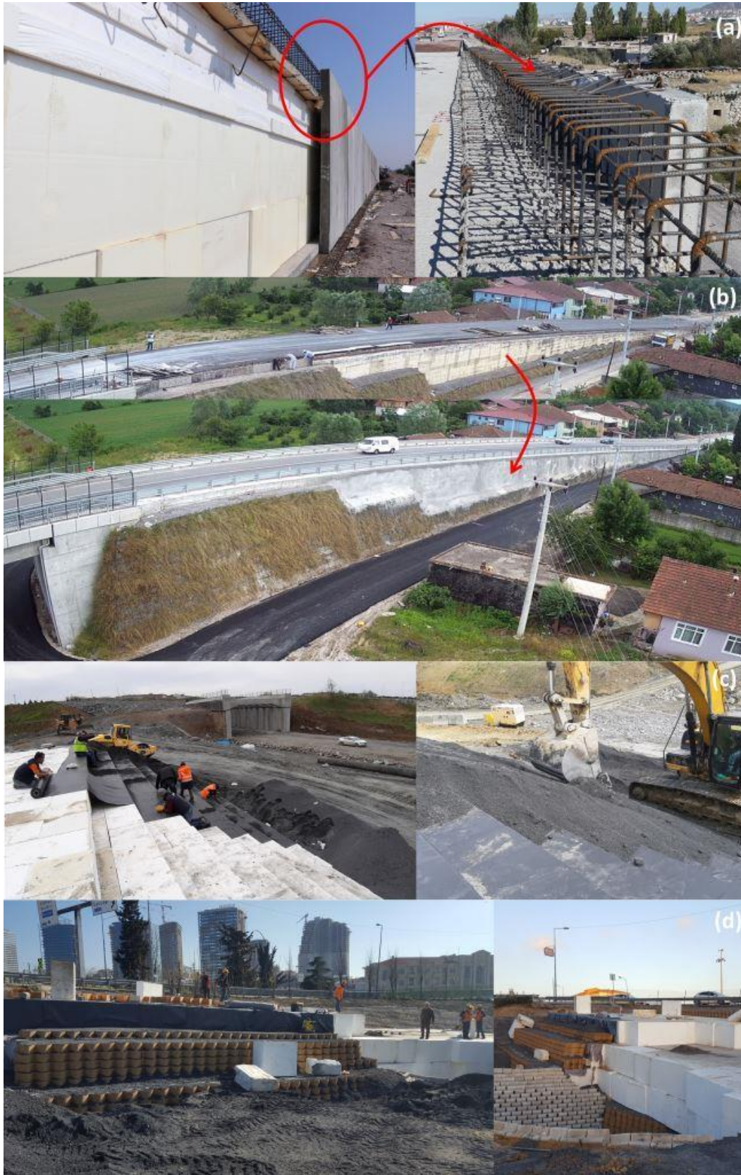
Şekil 8. Geofoam blok otoyol dolgularının dış etkenlerden korunması (a) Prekast panel, Boğazköprü, Kayseri (b) Donatılı püskürtme beton, KMO, Akyazı, Sakarya (c) Geomembran üzeri toprak örtü, KMO, İstanbul (d) Geomembran üzeri geohücre uygulaması, Acıbadem, İstanbul
