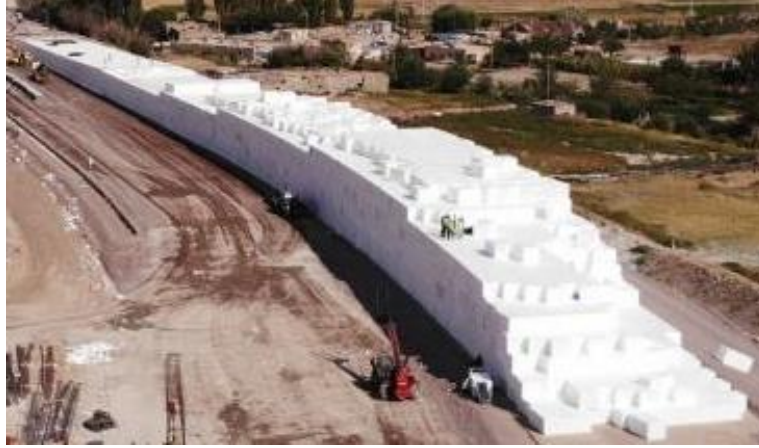
Şekil 7. Kurplu blok yerleşim planının sahada uygulanması, Boğazköprü/Kayseri
