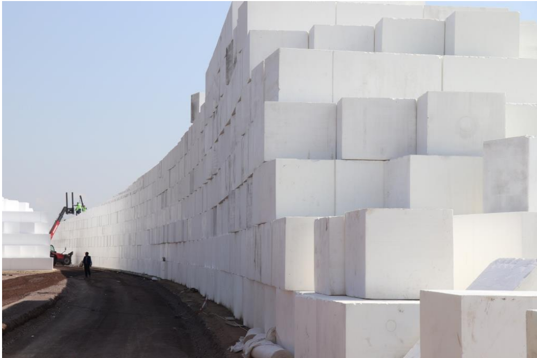
Şekil 6. Kurplu blok yerleşim planının sahada uygulanması, Boğazköprü/Kayseri
