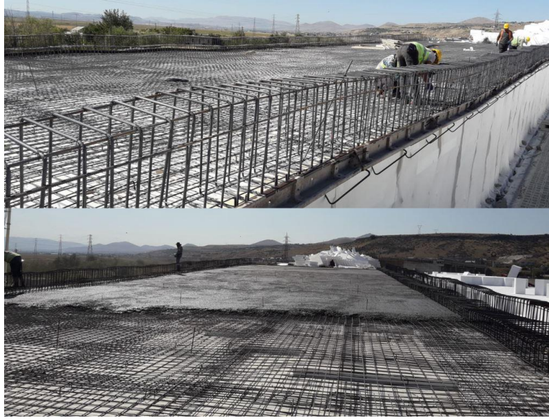
Şekil 9 Betonarme yük yayma platformu inşası, Boğazköprü, Kayseri
