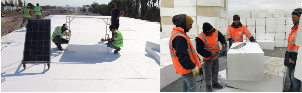
Şekil 5. Blokların sahada özel kesimlerinin yapılması (a) Sıcak tel kullanılarak, Boğazköprü/Kayseri (b) Elektrikli testere kullanılarak, KMO/İstanbul
