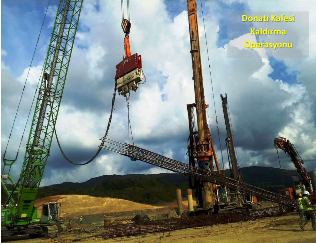
Şekil 6. Enstrümante edilmiş deney kazığı donatı kafesi kaldırma operasyonu genel görünüş
