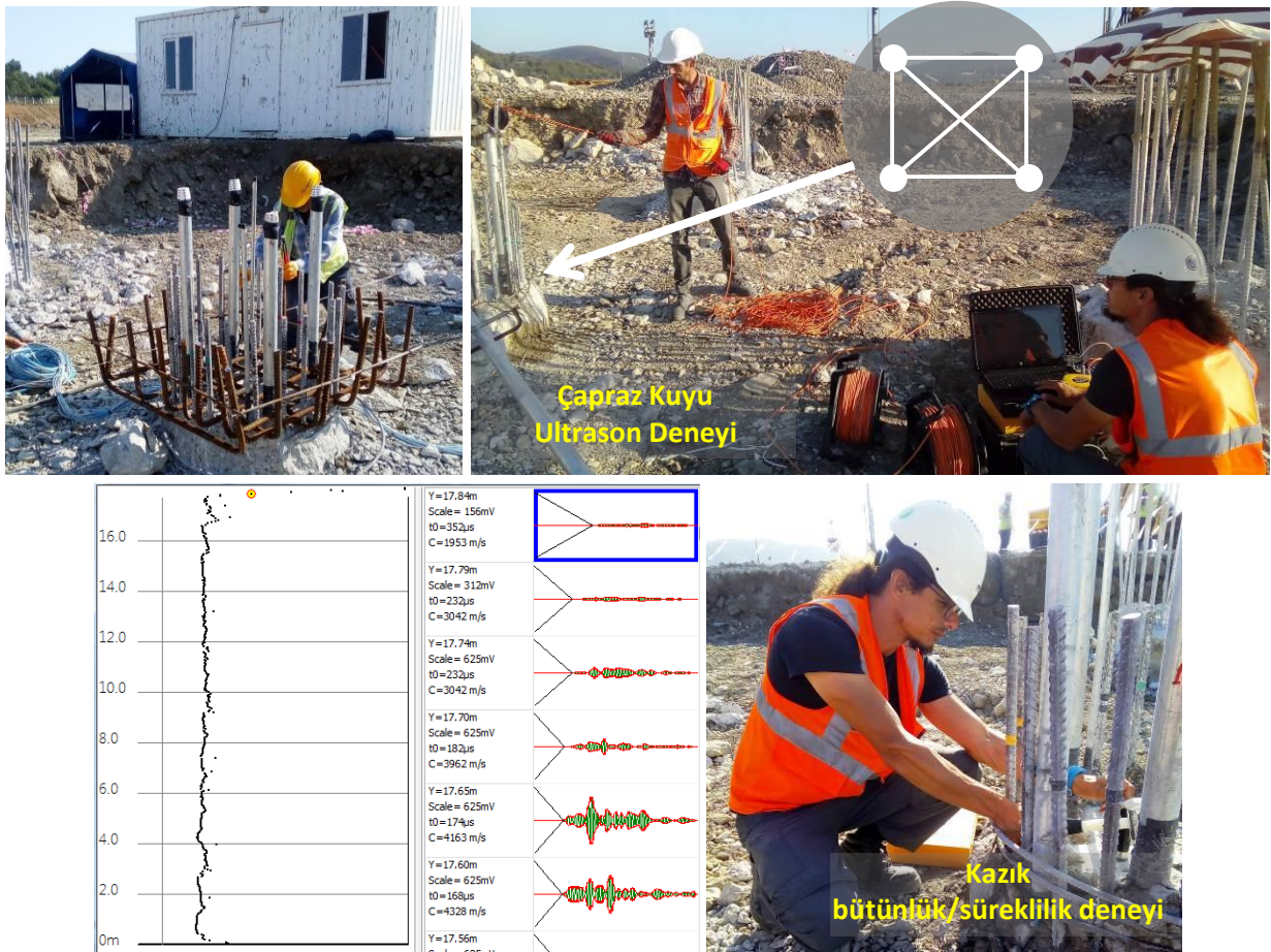
Şekil 7. Kazık bütünlük/süreklilik deneyi ve çapraz kuyu ultrason deneyi çalışmalardan genel görünüş
