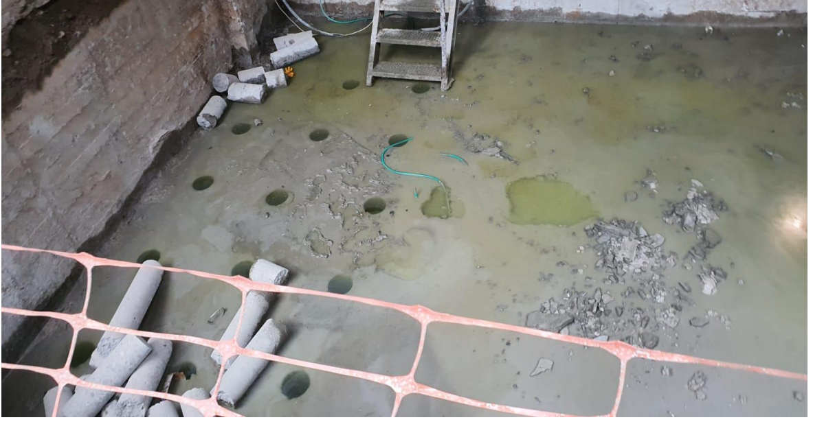
Şekil 7. Karot delim işlemi
