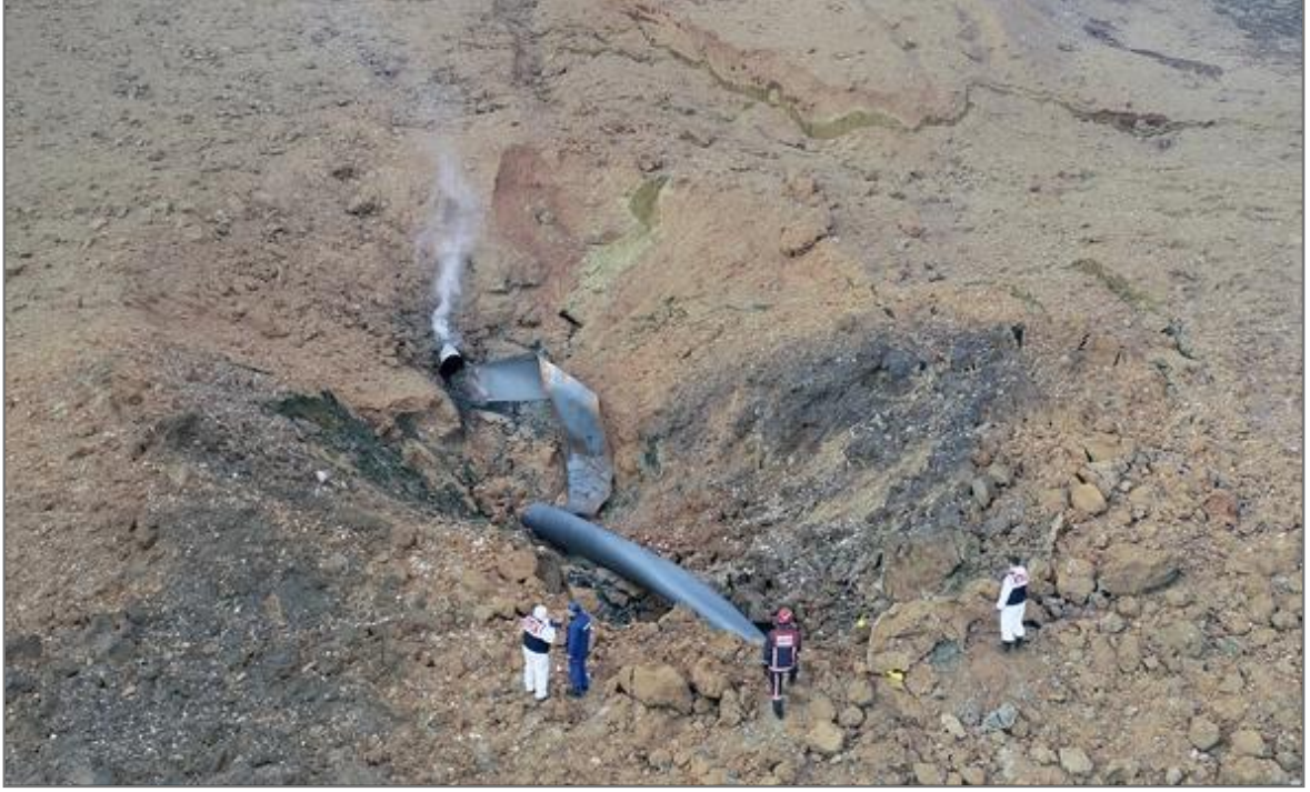
Şekil 1. Doğalgaz Borusu – Heyelan etkileşimi [Url-1]
