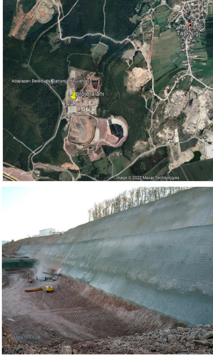
Fotoğraf 1. İnceleme alanı uydu görüntüsü ve şantiye alanı görüntüsü
