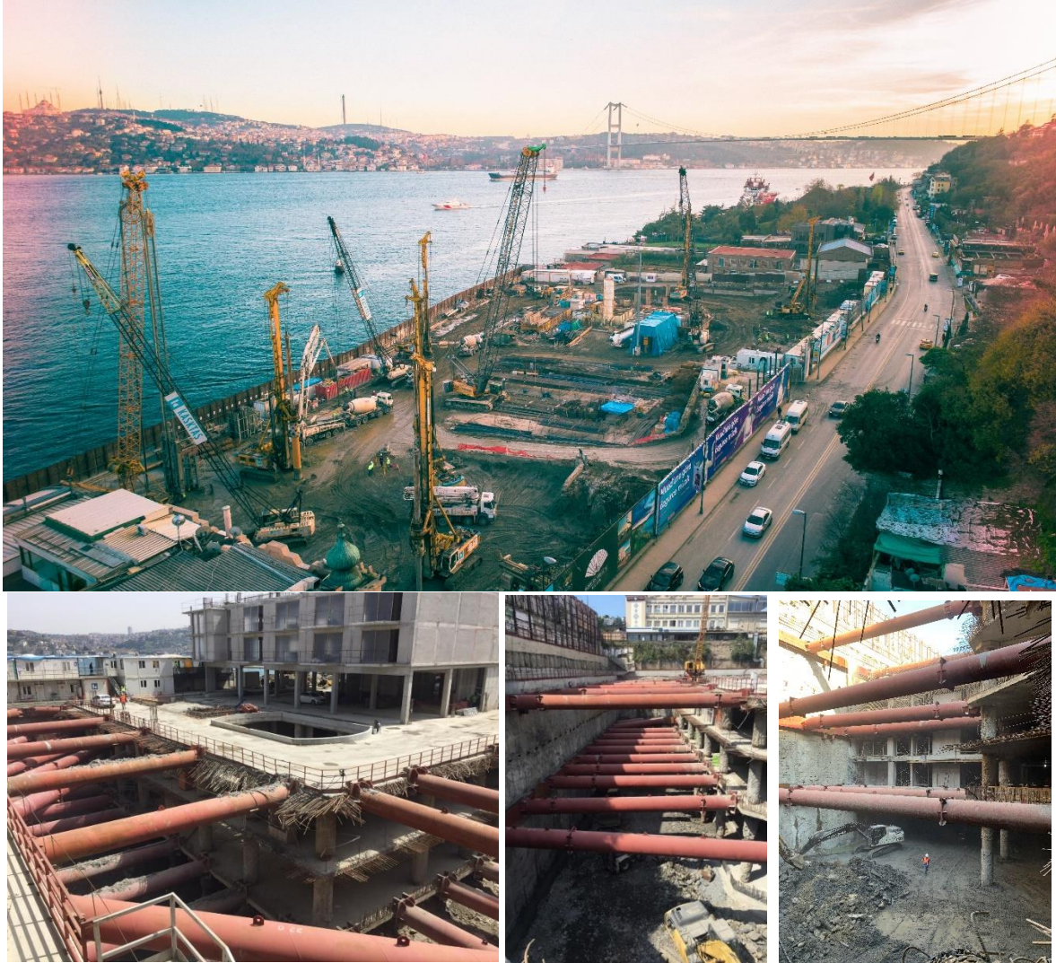
Şekil 7. İnşaat alanından fotoğraflar
