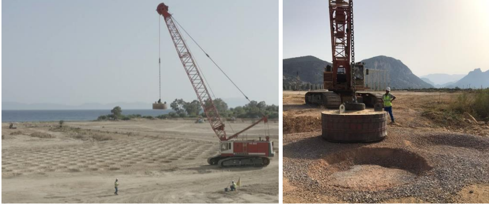
Şekil 5. Sahada dinamik sıkıştırma uygulaması
