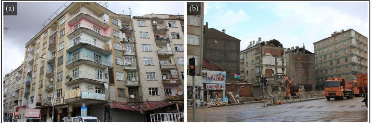
Şekil 7. Elazığ ili şehir merkezi tipik betonarme yapılar
