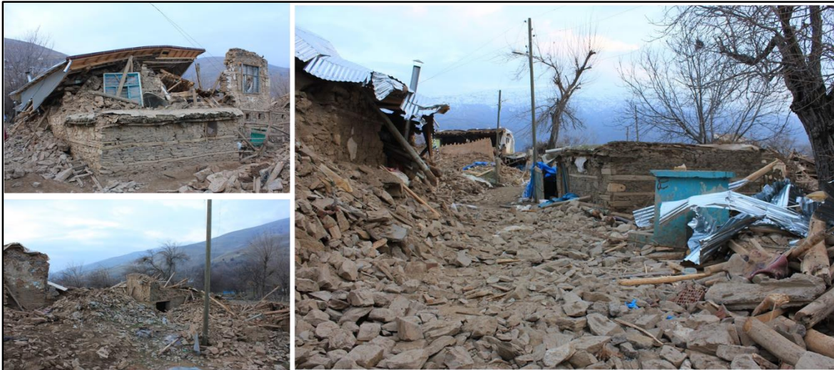
Şekil 9. Çevrimtaş köyünde tamamen yıkılan yığma yapılar
