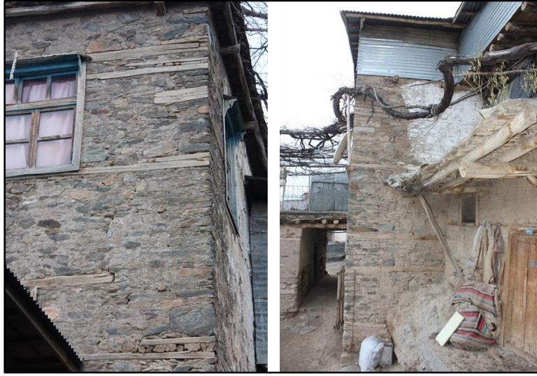
Şekil 10. Çevrimtaş Köyü'nde tepede bulunup hasar görmeyen yığma yapılar
