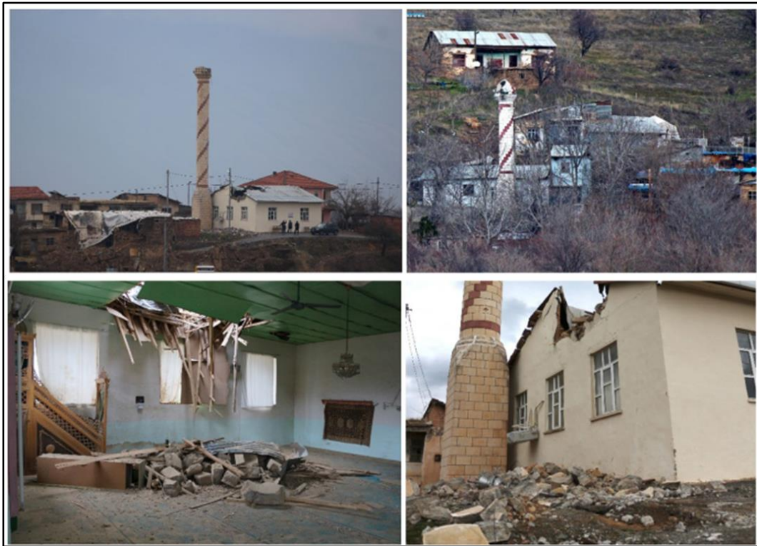
Şekil 12. Kısmi hasar gören, devirlen minareler ve camiilerin ibadethane kısmına verdiği zarar
