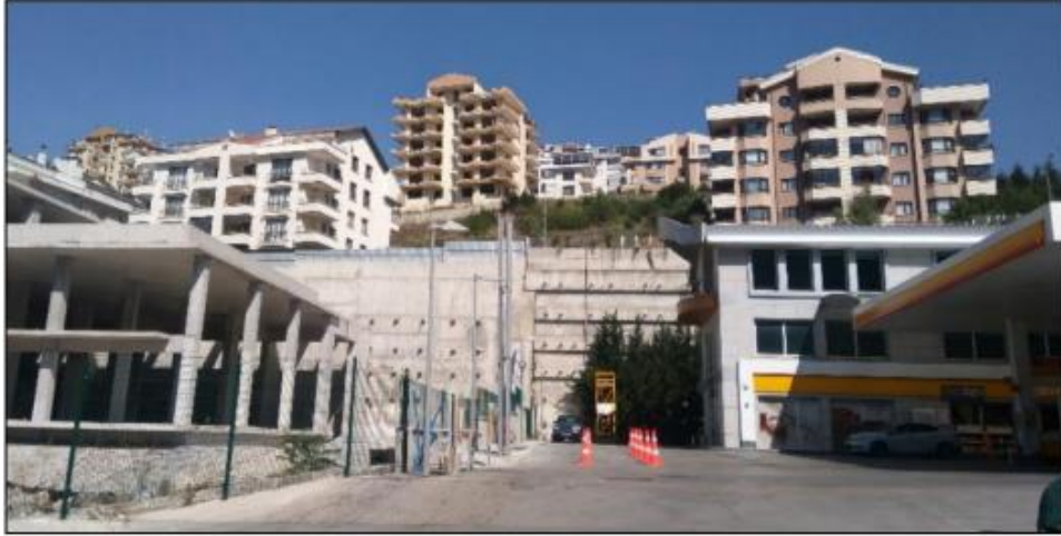
Şekil 1. Şevin topuğundan taç kısmına doğru bir görünüm (Temmuz 2019).
