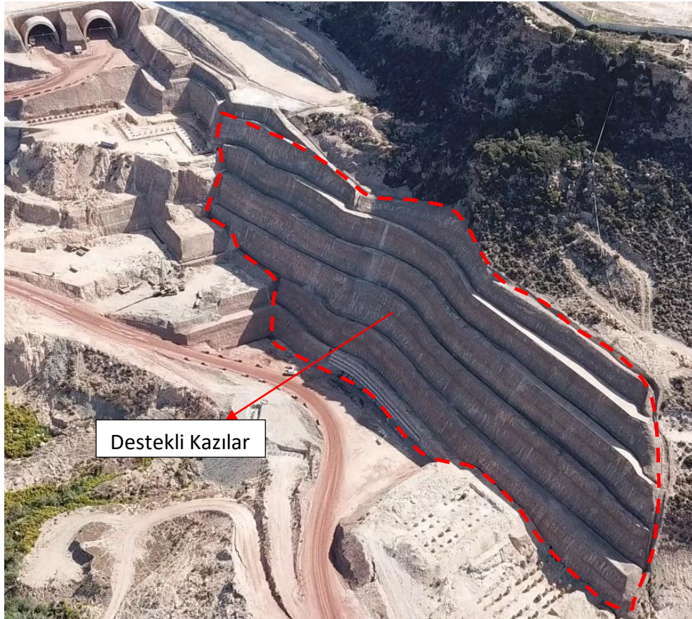
Fotoğraf 1. Viyadüğe ait destekli temel kazılarına ait genel görünüş
