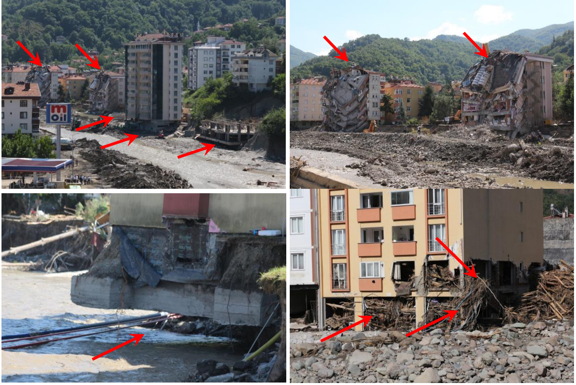
Şekil 2. Ezine Çayı boyunca binalarda gözlenen yapısal hasarlar ve temel altı oyulmalar
