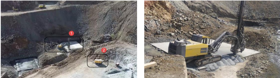
Şekil 7. Mini Kazıkların İmalatı (Viyadük Temellerinde)
